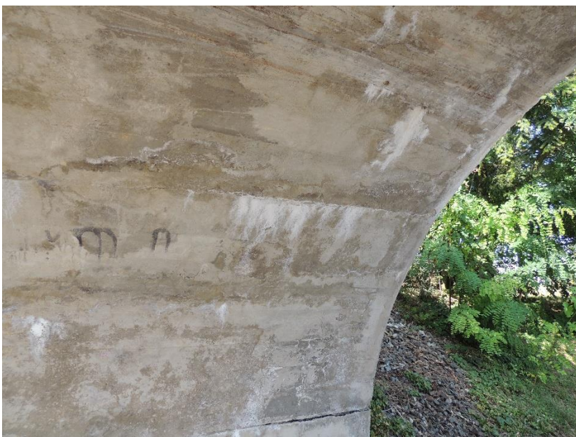
Pohled na další trhliny v klenbě K02
