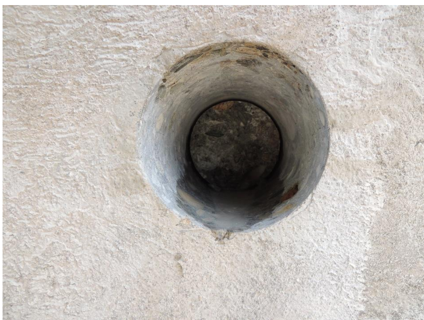
Pohled do otvoru po odběru vzorku betonu z opěry O01
