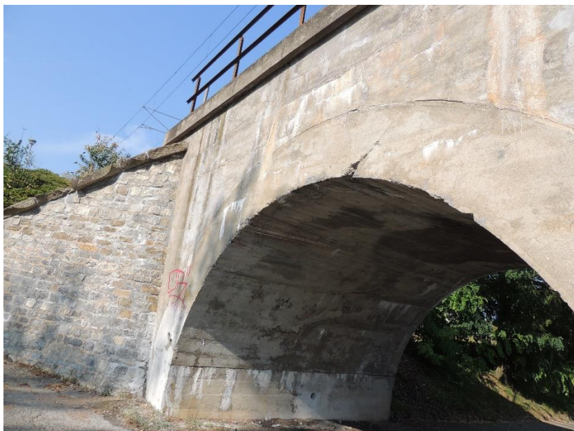
Pohled na trhlinu kopírující průběh horního líce klenby K02
