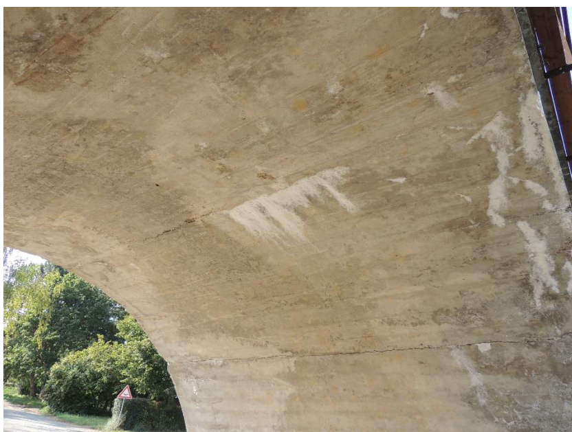
Pohled na trhliny v klenbě K01 s vápennými výluhy nad pilířem
