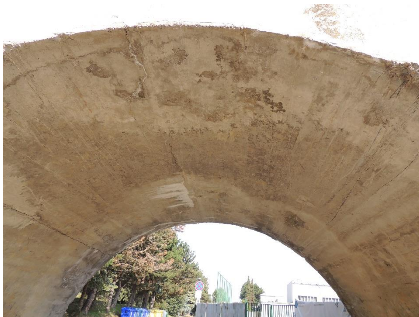
Pohled na spodní líc klenby K01 s poruchami ve formě trhlin
