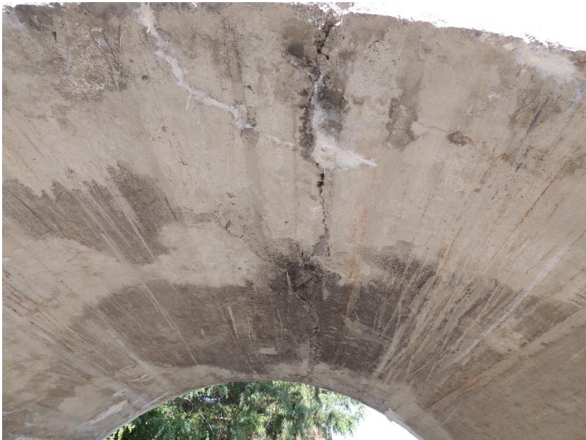
Pohled na trhlinu ve vrcholu klenby K02
